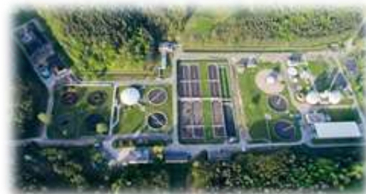
上下水道施設の監視制御
