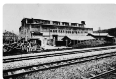
工場外観(1919年・北九州市)
