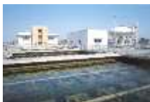
上下水道用電気 計装システム
