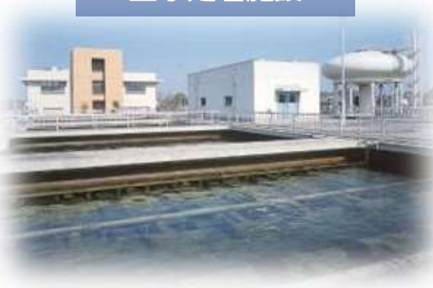
上水処理施設
