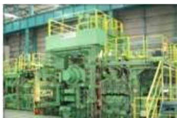
冷間延圧延機
