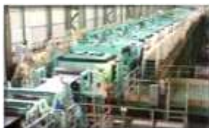
フ°㇑スライン設備
