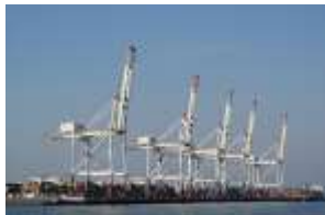
港湾クレーン
