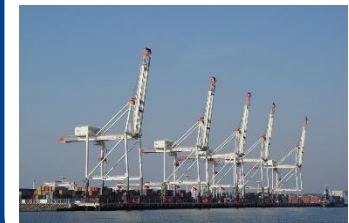
港湾クレーン
