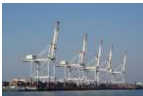
港湾クレーン
