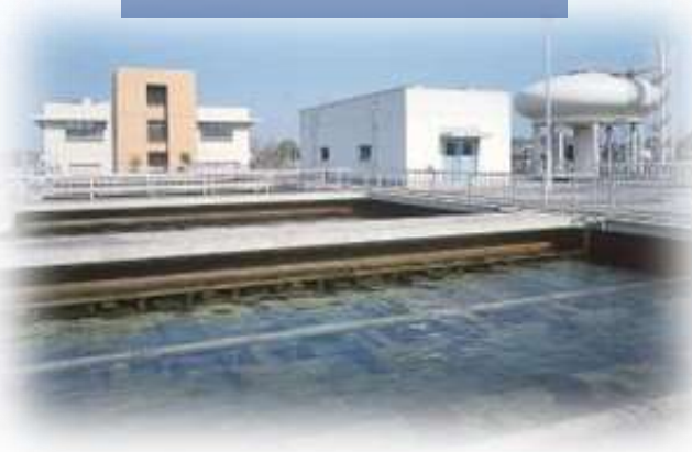
上水処理施設
