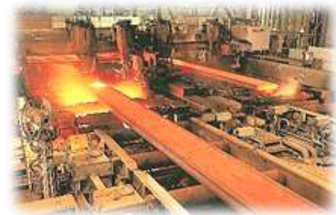
連続鋳造設備向け 制御システム・電気品提供
