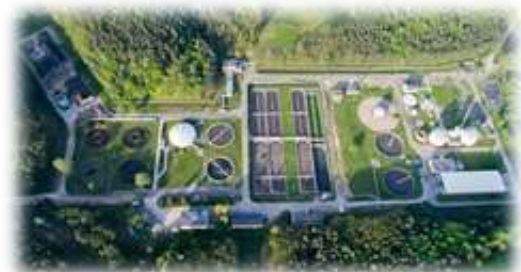
上下水道施設の監視制御
