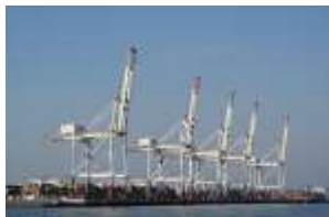
港湾クレーン
