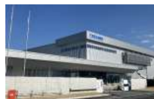
新設された南行橋事業所
