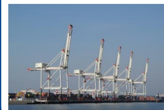
港湾クレーン
