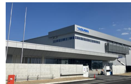
新設された南行橋事業所
