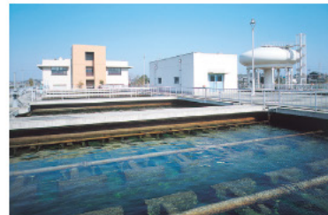
上下水道用電気システム
