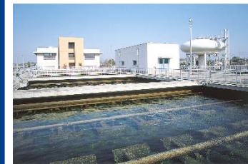
上下水道用電気 計装システム
