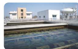
上下水道用電気計装システム
