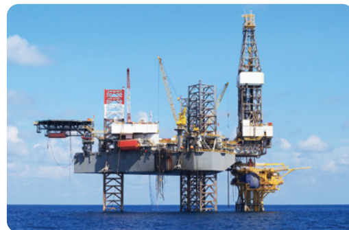
オイルガス掘削リグ
