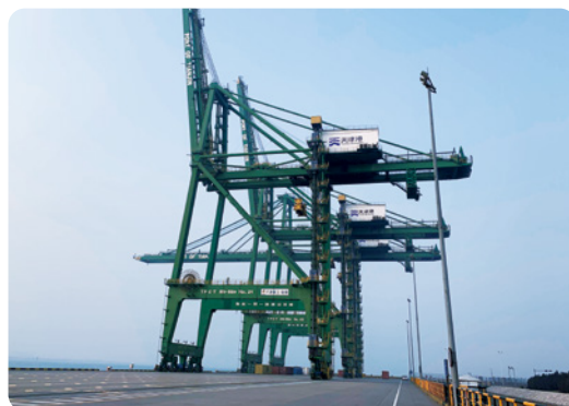
港湾クレーン
