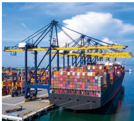
港湾クレーン
