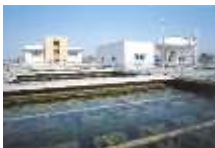
上下水道用電気 計装システム
