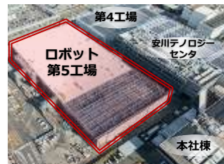
建設中のロボット第5工場
