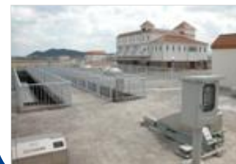
上下水道用 電気計装システム
