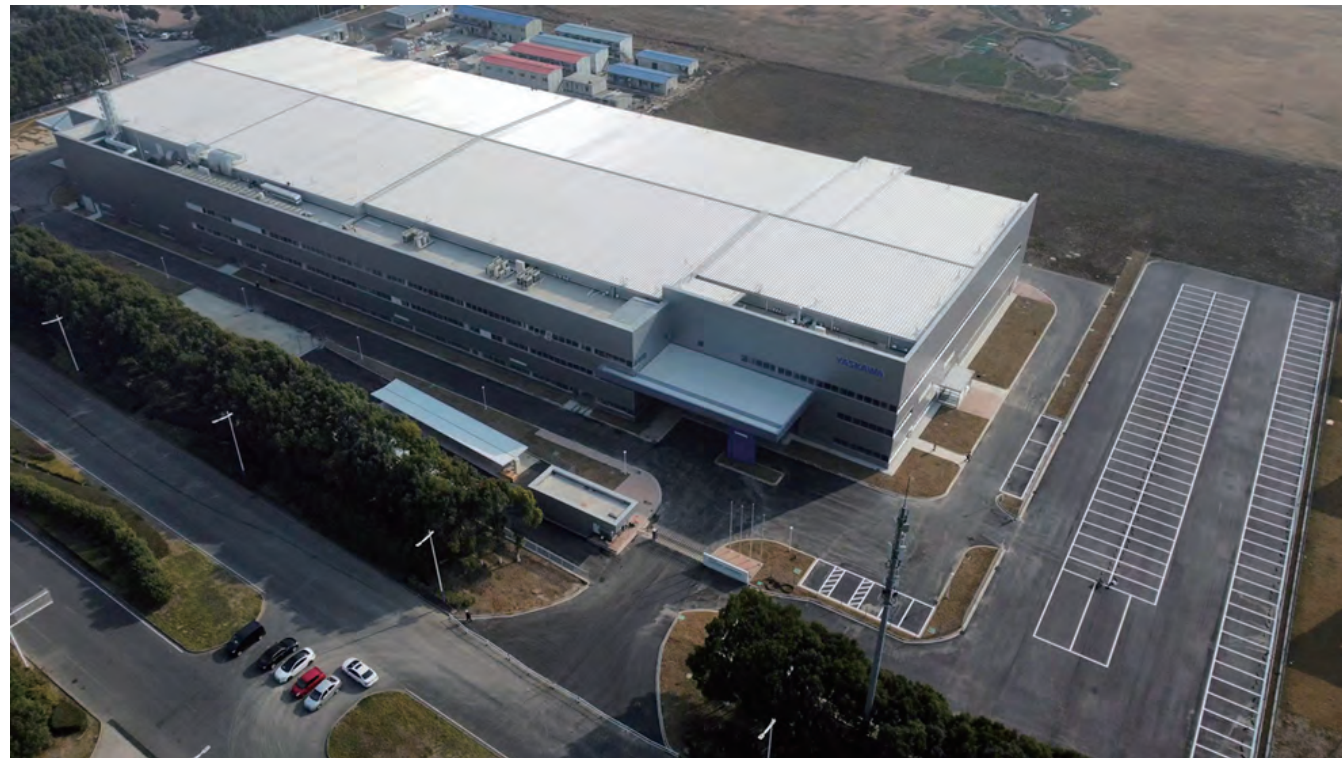
安川(常州)機電一体化系統有限公司の外観
