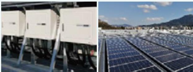
安川テクノロジーセンタ(2021年度開所)に搭載した当社製パワーコンディショナ「Enewell-SOL P2(左)」と「太陽光発電 295kW(右)」
