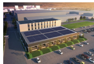
太陽光発電を導入した行橋事業所厚生施設
