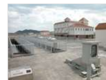
上下水道用 電気計装システム
