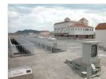
上下水道用 電気計装システム
