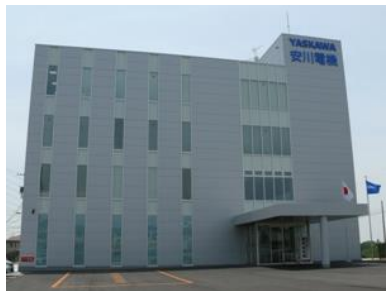
中部ロボットセンタ（外観）
