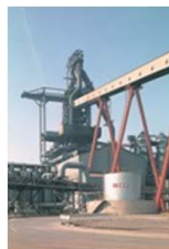
製鉄所の 監視制御装置
