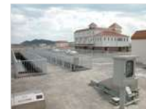
上下水道用 電気計装システム
