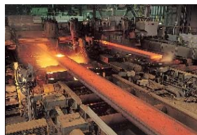
連続鋳造設備
