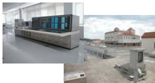
上下水道用電機システム
