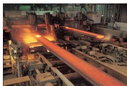
連続鋳造設備
