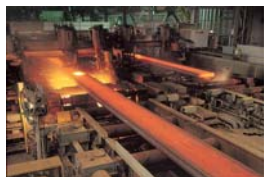
連続鋳造設備
