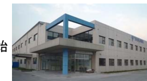
瀋陽第2工場(外観)
