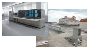
上下水道システム
