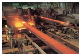
連続鋳造設備
