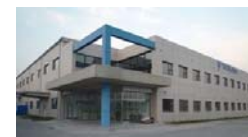
瀋陽第2工場(外観)
