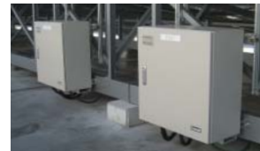
太陽光発電システムと当社製パワーコンディショナPV-1000
