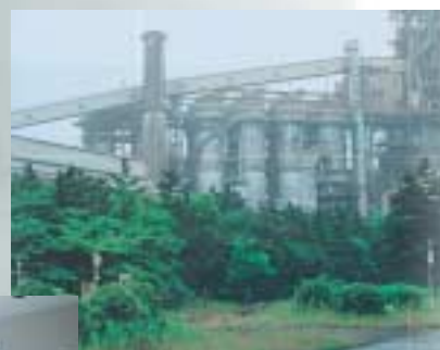
高炉設備と監視室
