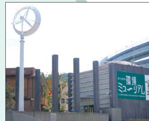
正面玄関（来館者入口）に設置された風レンズ風車*1
