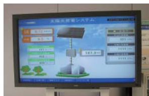
発電状況監視モニター
