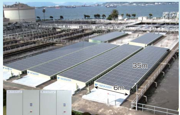
当社初の 大容量パワーコンディショナ*3 (100kW × 2セット)
