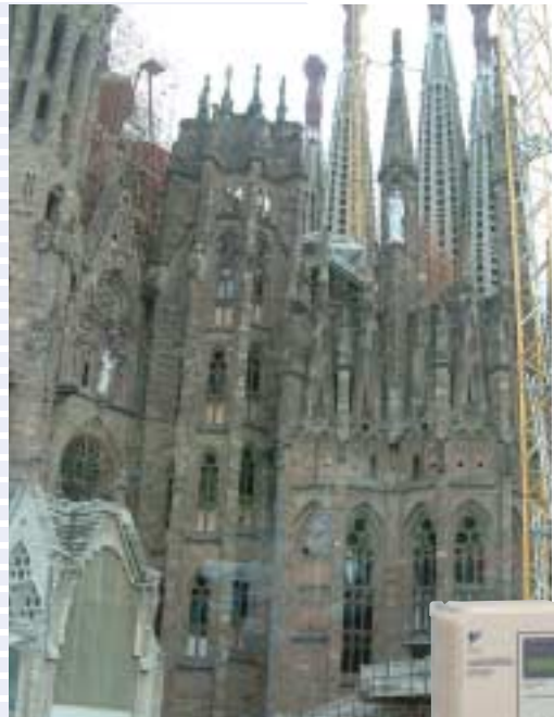
現在も建設中のサグラダ・ファミリア
