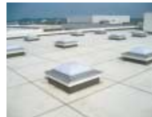
自然光を積極的に活用し、施設内照明の電力使用量削減を図っています。
