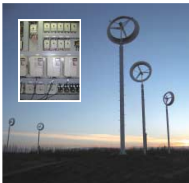
中国（甘粛省武威）に建設された風車と当社電機品が組み込まれた制御盤内部
