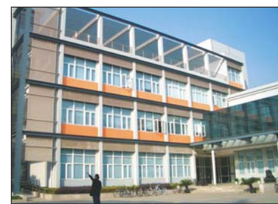
上海交通大学工程訓練センター
