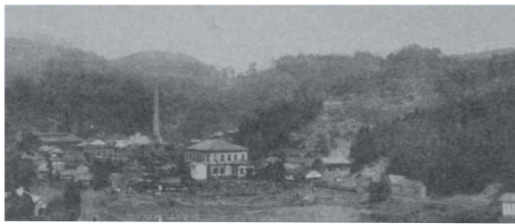
明治35年新築の明治炭坑社屋と明治第一坑
