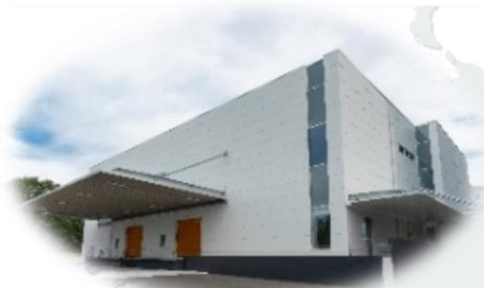
モーショントロール工場
