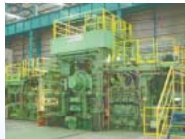
株式会社中山製鋼所様 スキンパスミル設備
