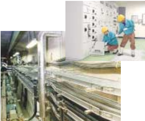
プラントシステムの配線工事
